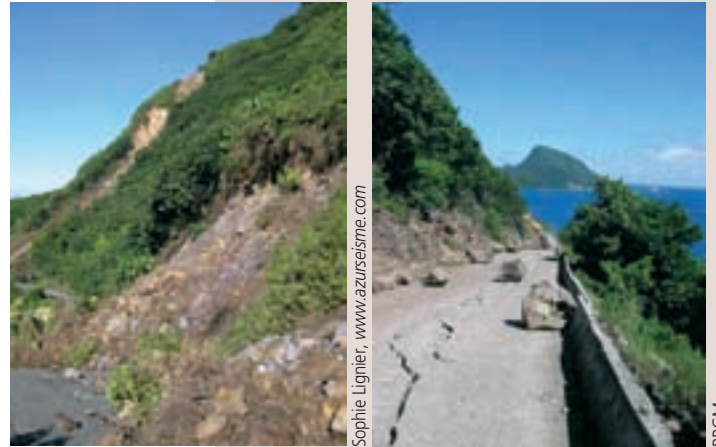
Mouvements de terrain à la Guadeloupe et sur l'île des Saintes (Antilles) après le séisme du 21 novembre 2004 (Photo de gauche : Sophie Lignier, http://www.azurseisme.com/GuadeloupeSeisme.htm ; Photo de droite : ©BRGM)
